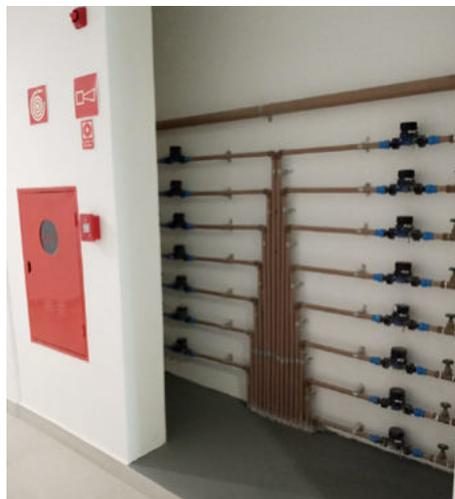
Imagem: Registros das prumadas, localizados no barrilete e medidores individuais de água fria, com identificação da respectiva unidade. Estão instalados nos shafts de cada pavimentos de apartamentos
