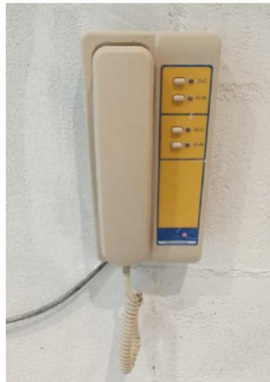
*Imagem: Interfone localizado nas áreas de hall de elevador nos pavimentos de garagem*
