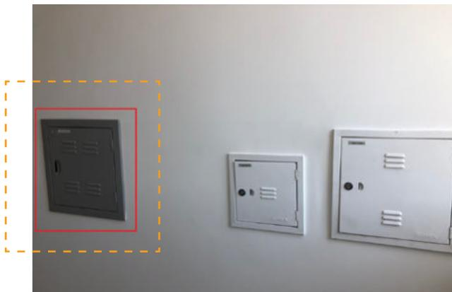
Imagem: Caixa de passagem nos pavimentos e aparelho instalado nos apartamentos
